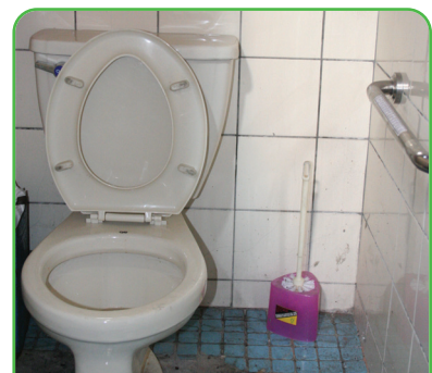
▲原本上蹲式廁所（上圖）時既不方便又危險，賀小姐申請在坐式廁所（下圖）安裝扶手，解決如廁不便。
